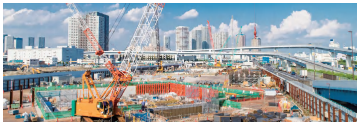
建設現場での電源確保
